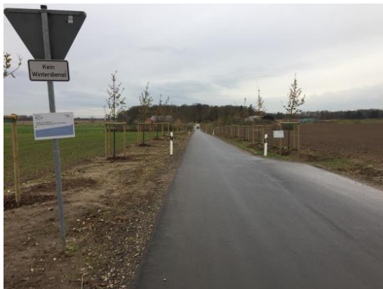
Das Foto zeigt den fertig ausgebauten Rögener Weg.
