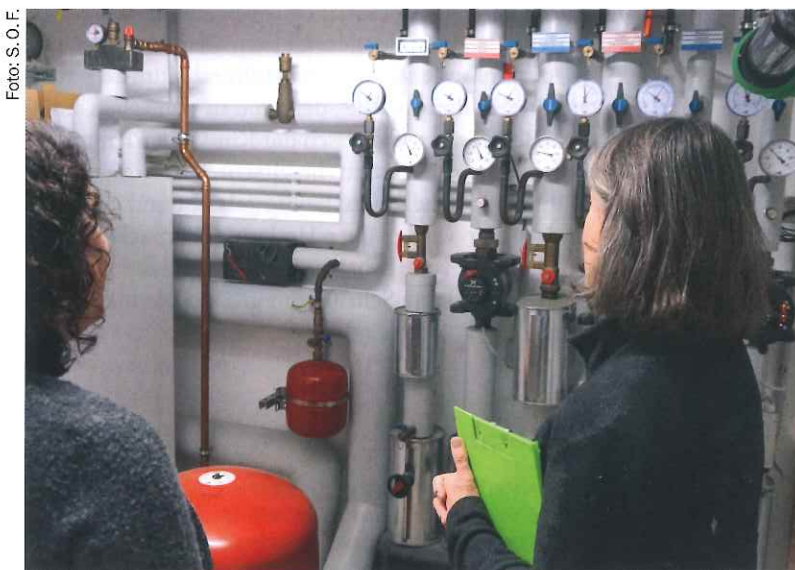
Bei einer Gebäudebegehung mit einer professionellen Energieberaterin wird für jede Kita ein Energie-Check durchgeführt.
